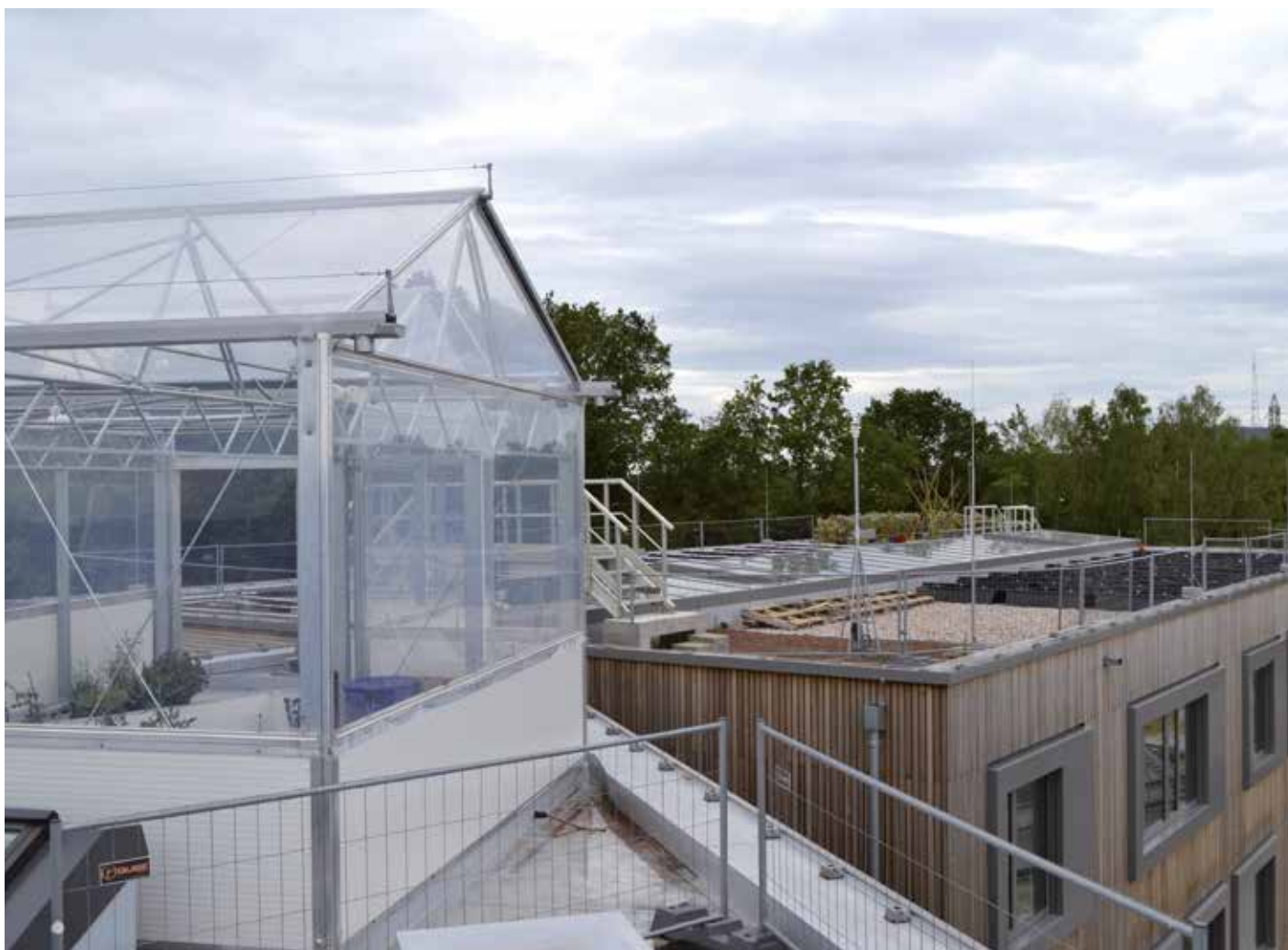
Le toit accueille une serre urbaine qui a pour objectif de proposer des solutions innovantes liées à l'économie circulaire.
